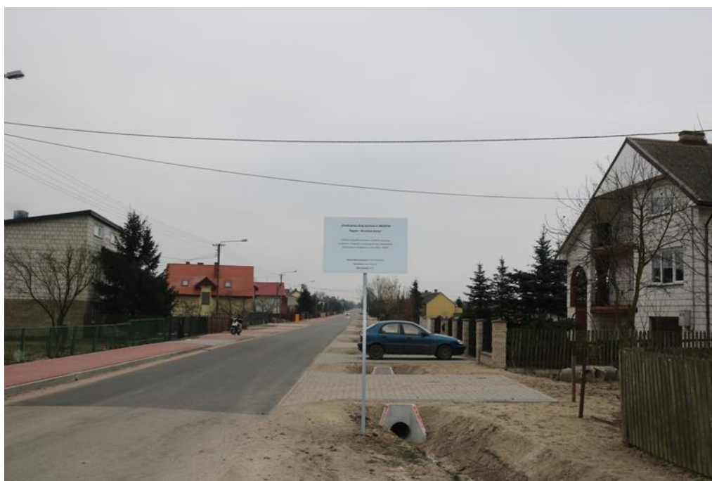
Przebudowa drogi gminnej Rogów – Bieszków Górny.
